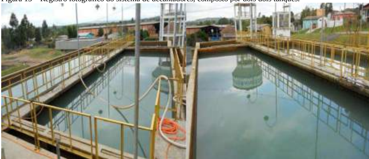
Figura 15 – Registro fotográfico do sistema de decantadores, composto por dois dois tanques.
