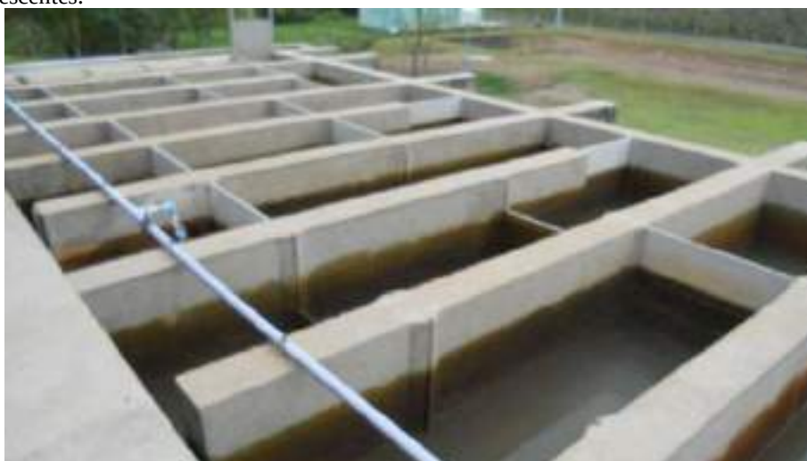
Figura 15 – Registro fotográfico do sistema de decantadores, composto por dois dois tanques.
