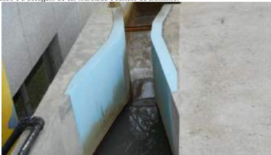
Figura 13 – Registro fotográfico da entrada de água bruta na ETA Arroio dos Ratos com calha Parshal, onde é realizada a medição da vazão e a dosagem de cal hidratada e sulfato de alumínio.
