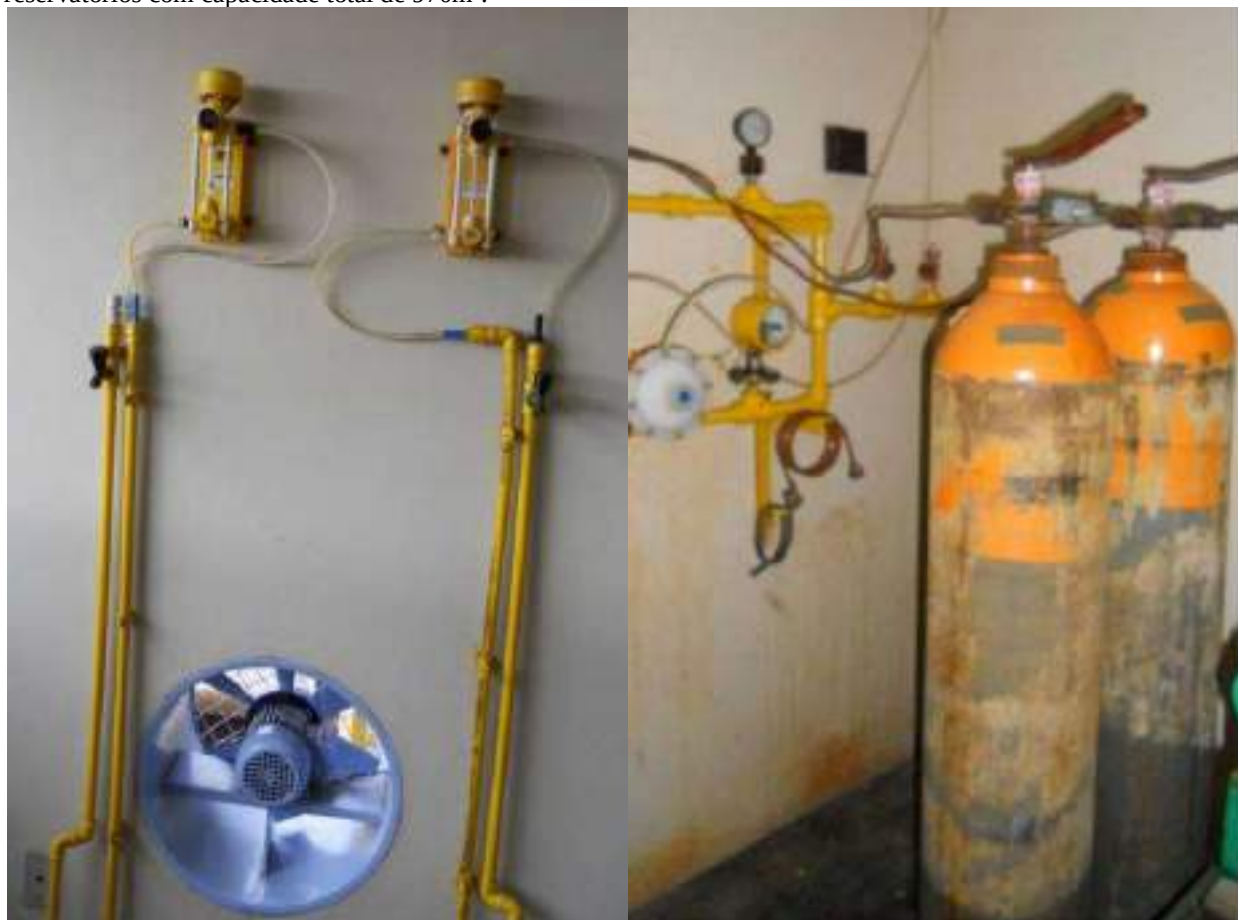
Figura 17 – Registro fotográfico dos sistemas de dosagem de flúor e de cloro, sendo armazenada em cinco reservatórios com capacidade total de 970m 3 .
