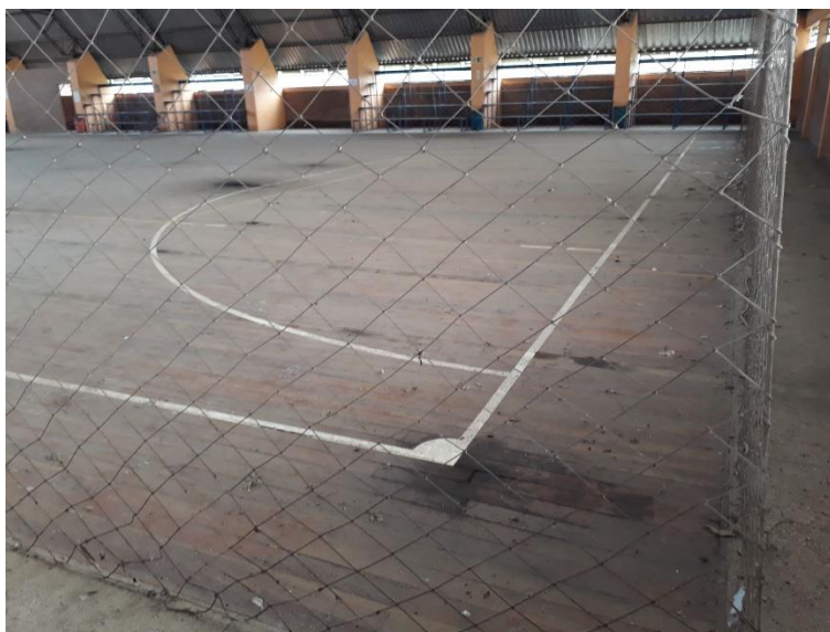
Figure 9: Detalhe piso em madeira
