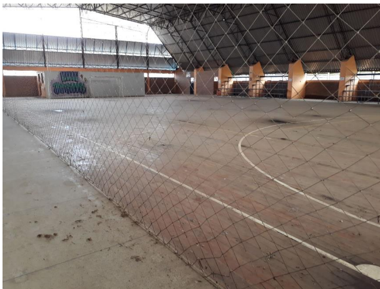
Figure 6: Piso da quadra em madeira
