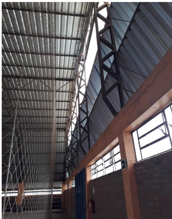
Figure 8: Estrutura do telhado
