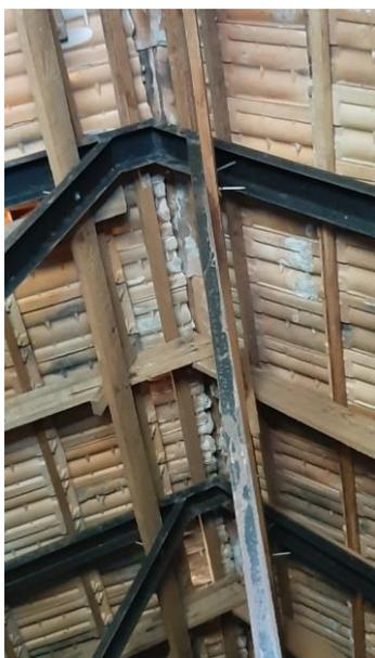
Visual do telhado já substituído por estrutura metálica.
