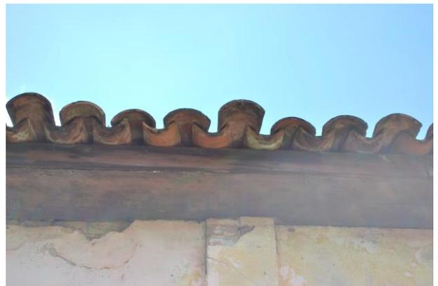
Beiral de capa-e-canal. Forro de madeira. Pilastra de alvenaria.
