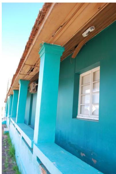
Detalhe dos pilares com capitéis simplificados e do peitoril de alvenaria.
