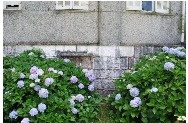
Detalhe da ventilação do porão.
