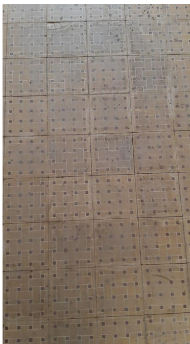
Piso de ladrilhos hidráulicos.
