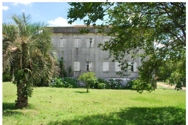
Antigo bloco da Puericultura. Revestimento de Fulget.
