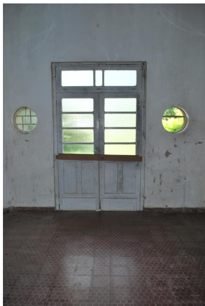
Vista interna do acesso.
