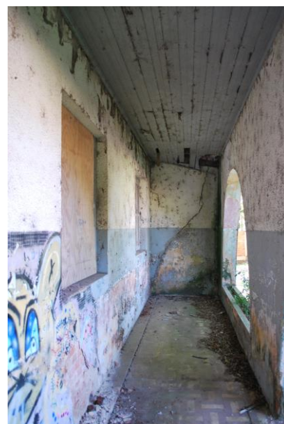
.Varanda, forro de madeira e piso de ladrilhos hidráulicos. Floreira.
