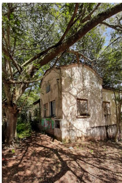
Vista do torreão lateral.
