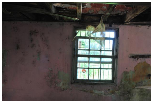
Vista interna dos fundos, porão.
