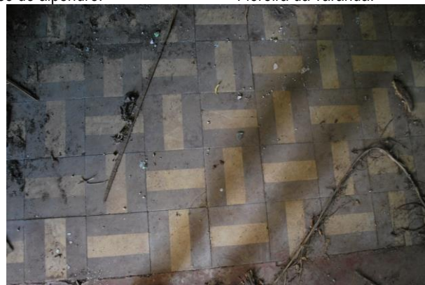
Ladrilhos hidráulicos no porão.
