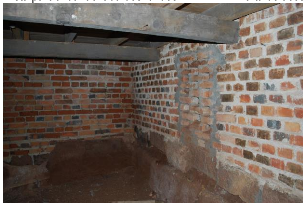
Vista das fundações de pedra e de alvenaria. Porão.
