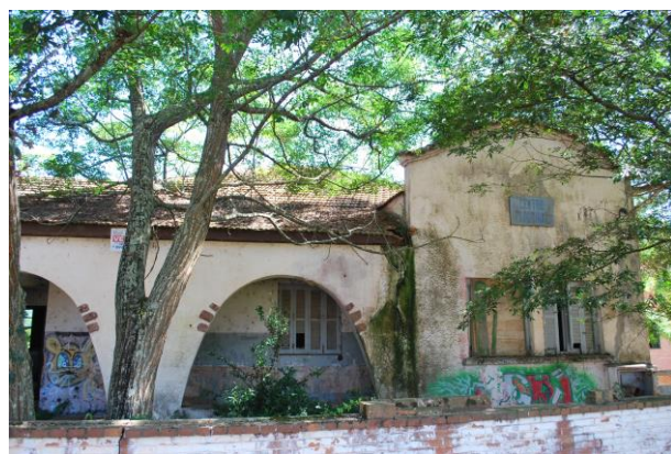
Vista parcial da fachada principal.
