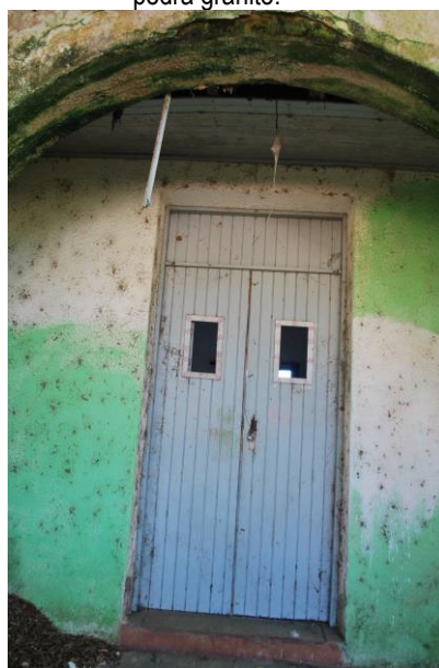
Porta de acesso do alpendre.
