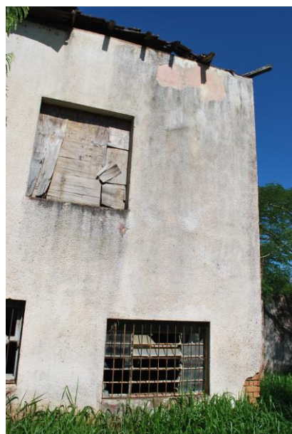
Vista parcial da fachada dos fundos.
