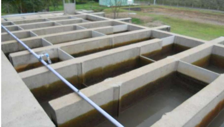
Figura 9 – O sistema de floculação é tipo chicanas, composto de 07 (sete) câmaras, com gradientes decrescentes.
