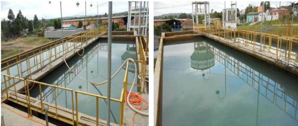
Figura 10 – O sistema de decantadores é formado por dois tanques de fluxo ascendente.
