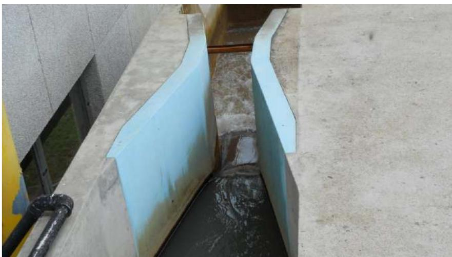
Figura 8 – A entrada de água bruta na ETA Arroio dos Ratos é quantificada pela calha Parshal, onde recebe a cal hidratada e sulfato de alumínio.
