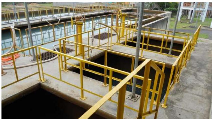
Figura 11 – A filtração é do tipo rápido, formado por carvão e areia distribuídos em 06 (seis) unidades filtrantes.
