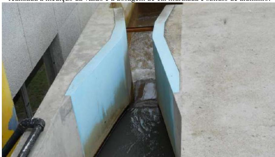
Figura 14 – Registro fotográfico do sistema de floculação, que é tipo chicanas, composto de sete câmaras, com gradientes decrescentes.
