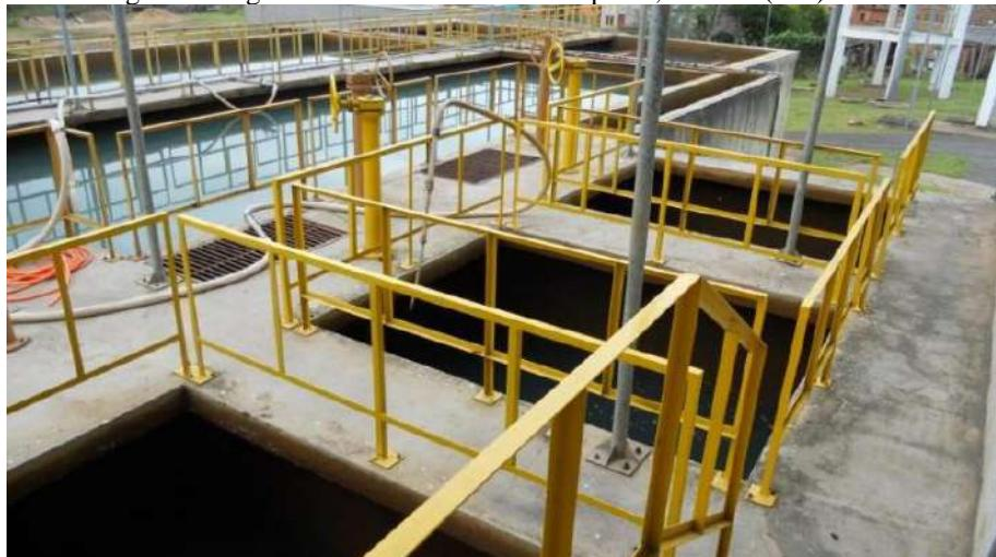
Figura 17 – Registro fotográfico dos sistemas de dosagem de flúor e de cloro, sendo armazenada em cinco reservatórios com capacidade total de 970m<sup>3</sup>.
