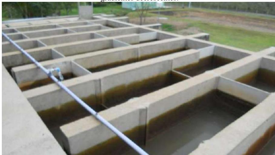
Figura 15 – Registro fotográfico do sistema de decantadores, composto por dois tanques.
